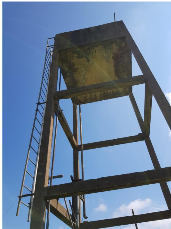
Figura 4.26 – Infraestrutura do reservatório do Matarazzo
