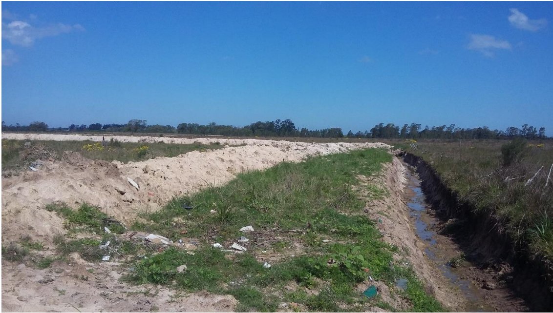
Figura 7.14. Canal artificial de terra localizado sob as coordenadas 31°52'7.62"S e 52°49'42.85"O
