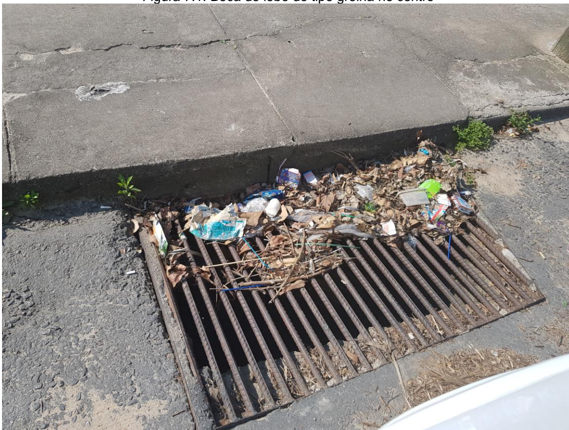
Figura 7.1. Boca de lobo do tipo grelha no centro
