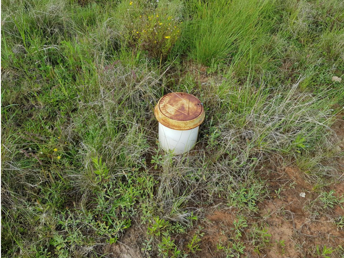
Figura 6.25. Piezômetro instalado para monitoramento do aterro desativado
