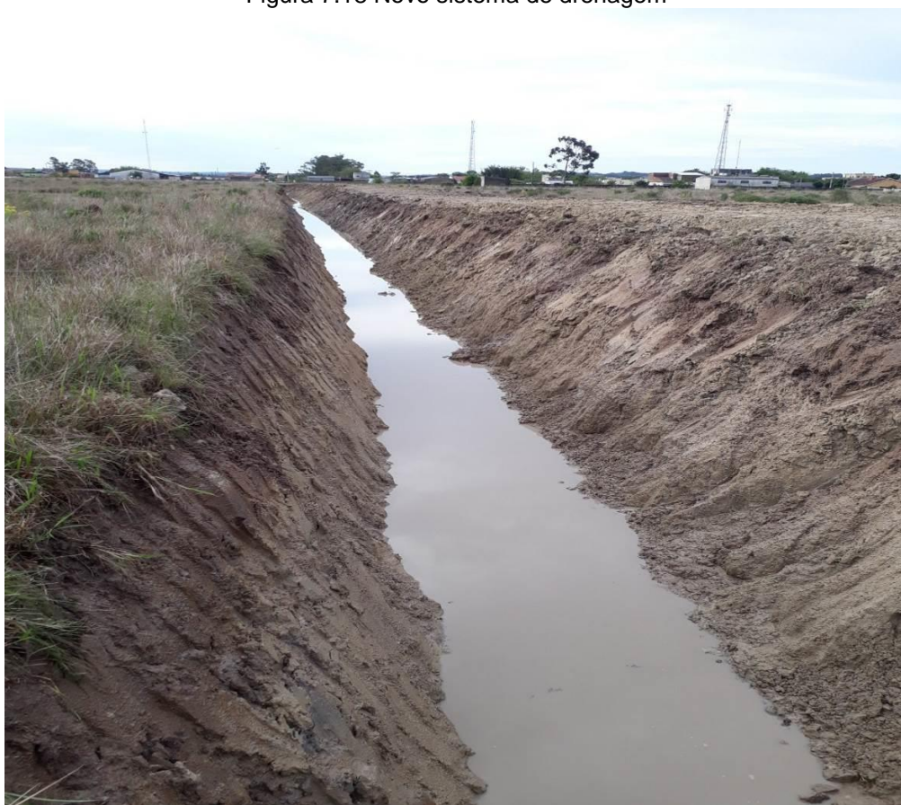
Figura 7.18 Novo sistema de drenagem
