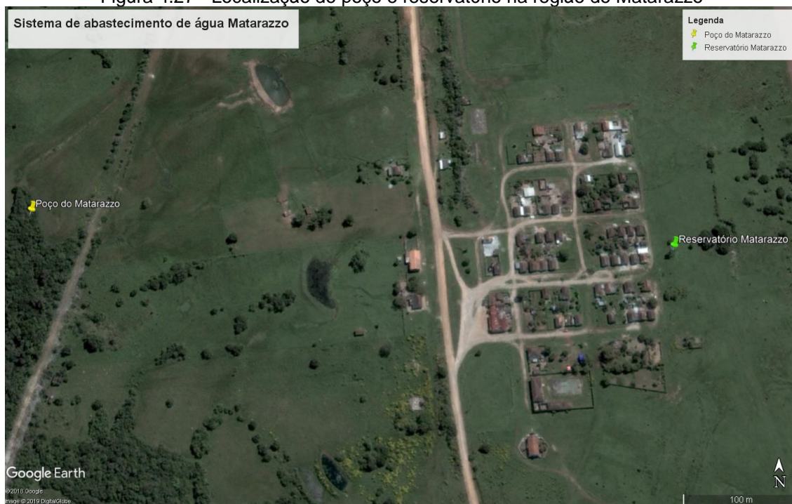
Figura 4.27 - Localização do poço e reservatório na região do Matarazzo
