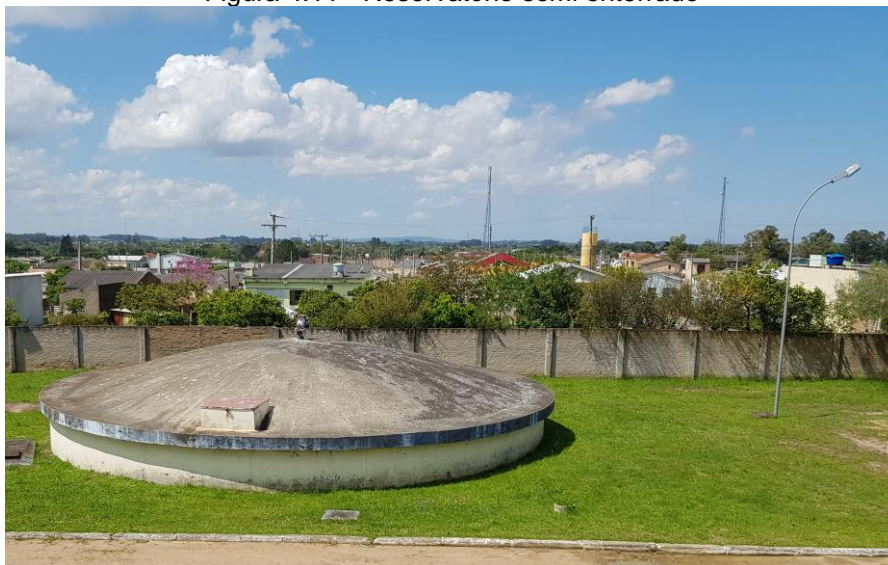
Figura 4.11 - Reservatório semi enterrado
