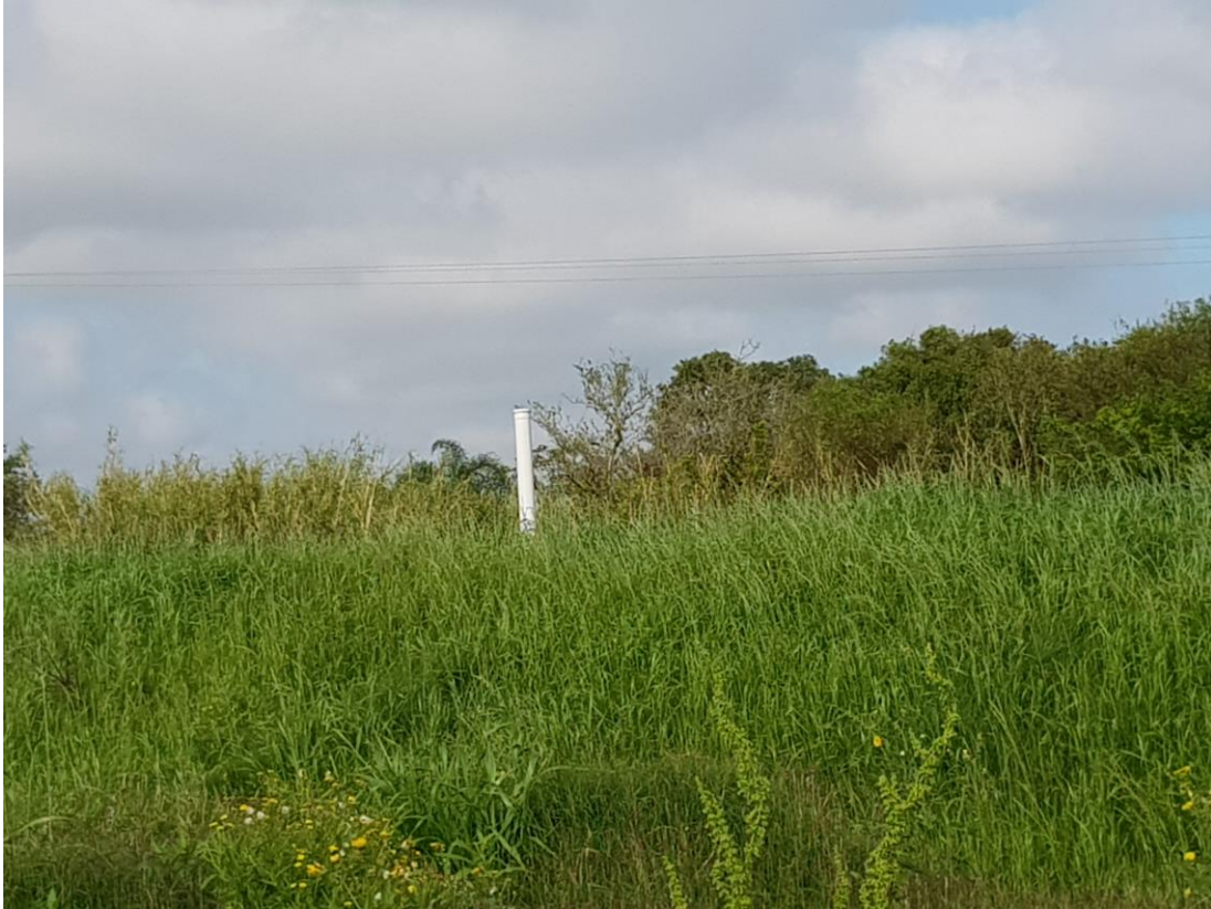
Figura 6.27 - Dreno para gases gerados pelo aterro
