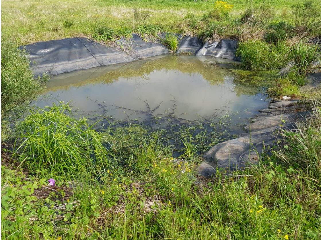
Figura 6.31 - Lagoa de tratamento de chorume maior
