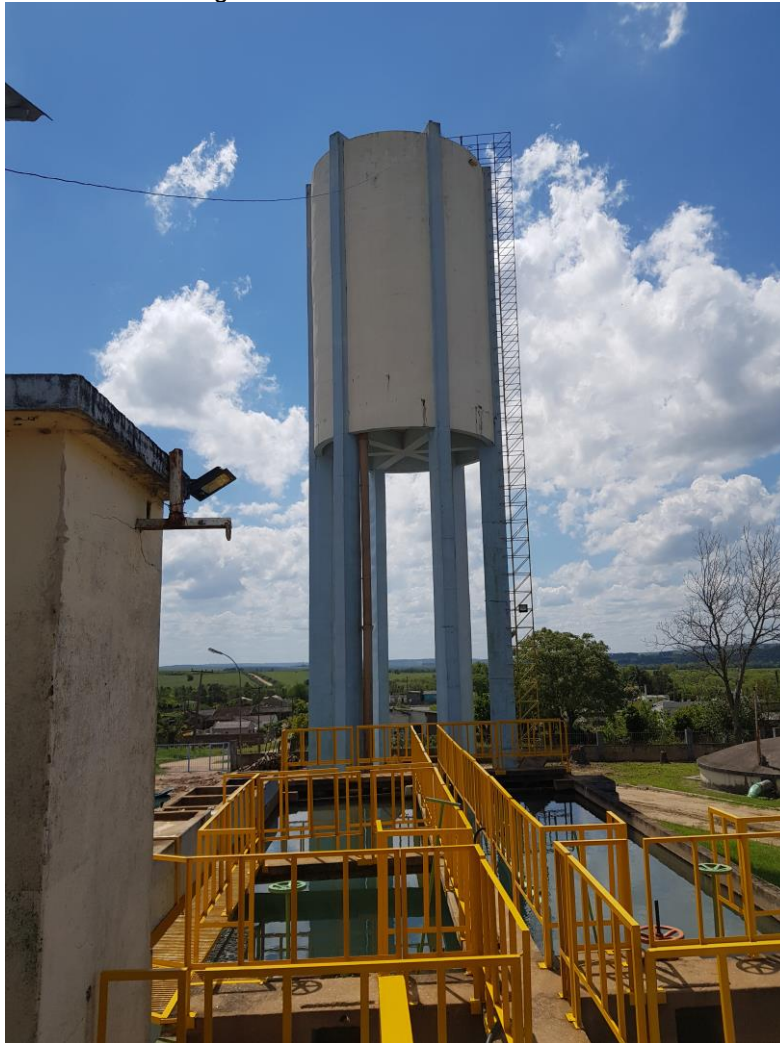
Figura 4.10 - Reservatório elevado
