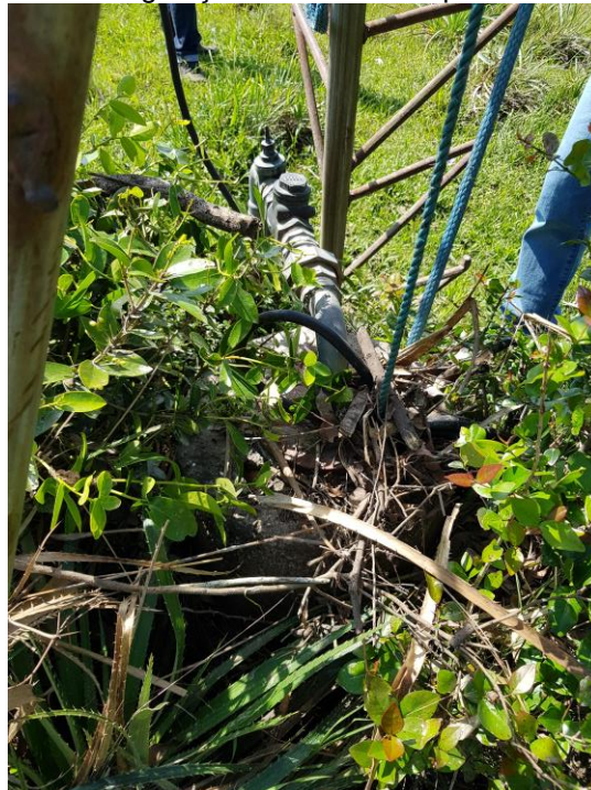
Figura 4.22 – Vegetação no entorno do ponto de captação
