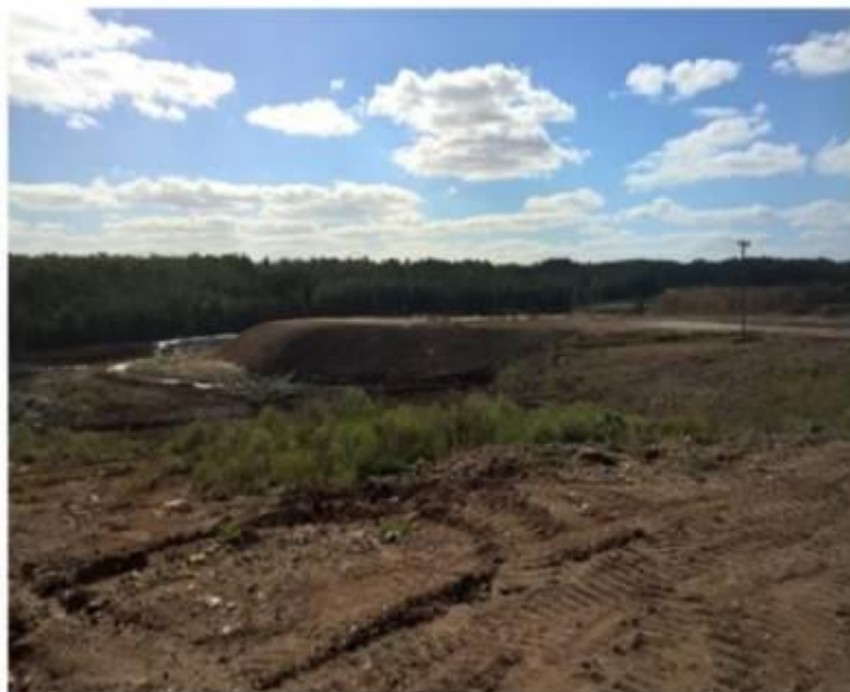
Figura 6.14 - Vista do aterro sanitário Metade Sul - Candiota/RS
