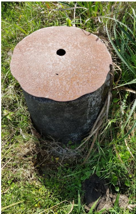
Figura 4.23 - Poço profundo desativado
