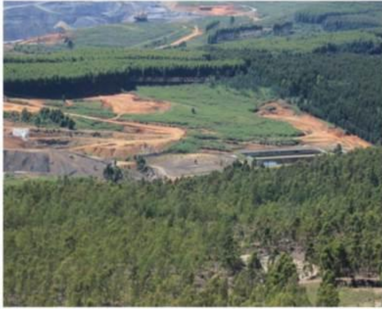
Figura 6.15 - Vista do aterro sanitário Metade Sul - Candiota/RS
