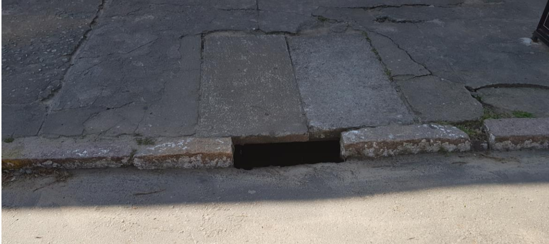
Figura 7.2. Boca de lobo do tipo guia no centro
