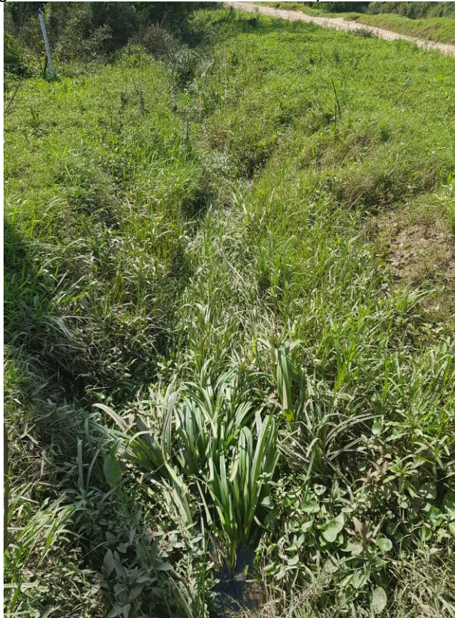
Figura 6.20. Canal de descarte do lodo proveniente da ETA
