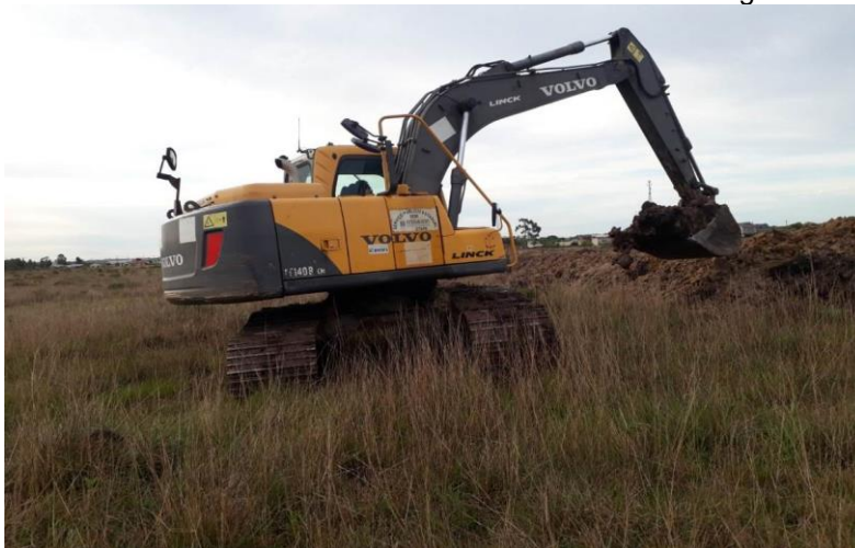
Figura 7.17 Escavadeira hidráulica executando novo canal de esgotamento pluvial
